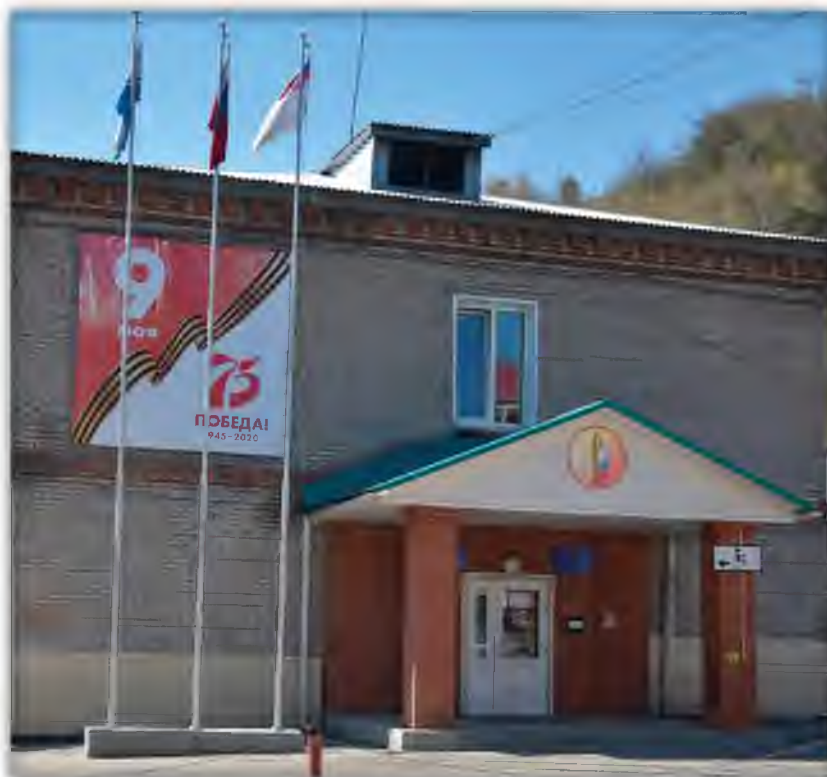
Здание, в котором расположилось Министерство сельского хозяйства по улице Северная, 12
